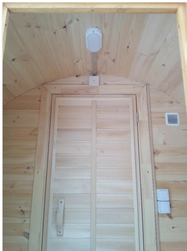
Светильник, выключатель и розетка в раздевалке.
